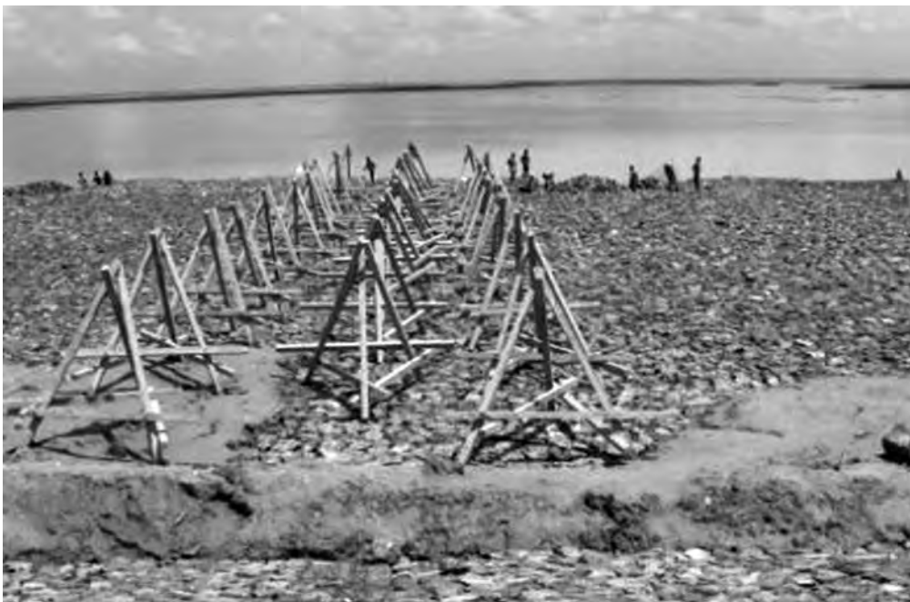
Fig. 7.3(d) Prismatic type RCC Porcupine
