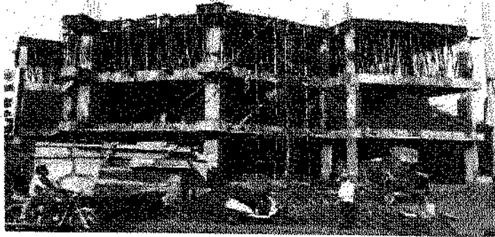
राजकोट कार्यालय भवन निर्माण स्थल Rajkot office building construction site
